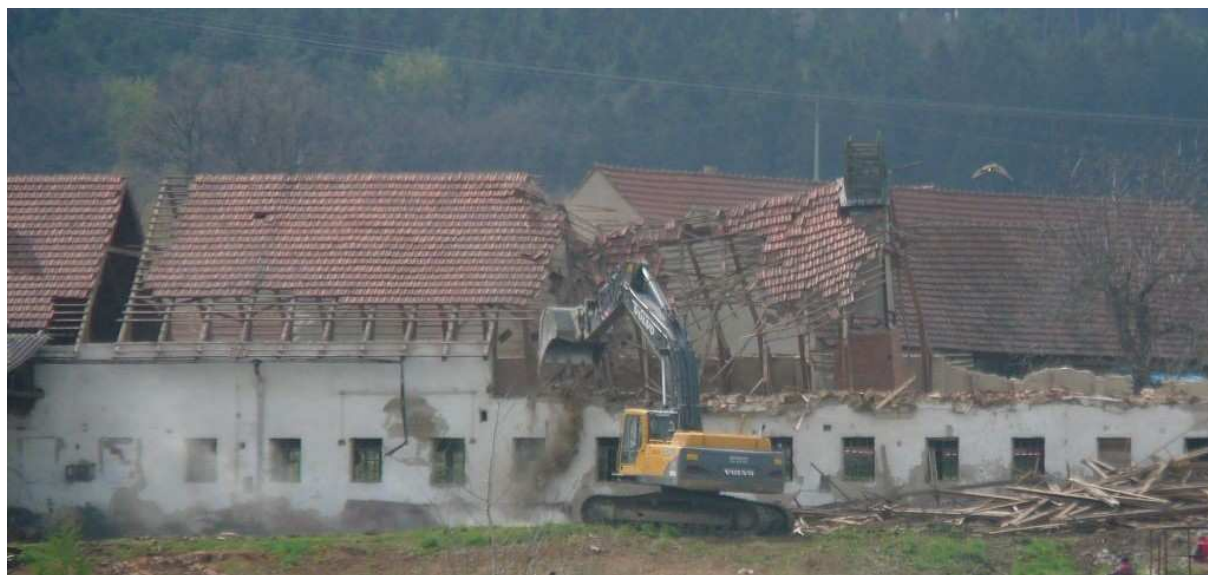
Bourání budovy kravína – duben 2008
